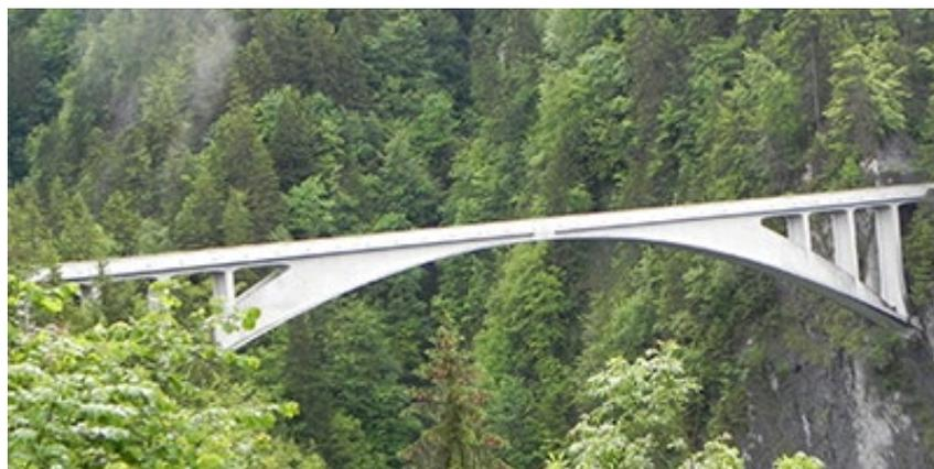
Figura 1. Puente Salginatobel (1930), Suiza: arco de tres articulaciones en caja hueca de hormigón armado, 90 m de luz [1]
